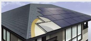
太陽電池モジュールを屋根の野地に直接設置する独自の工法「野地ぴたF方式」。パネル部分の瓦葺きが不要で、家作りのコストを節約できます。瓦がない分、屋根が軽くなり、揺れに強い「減震※1」仕様の住まいになります。
