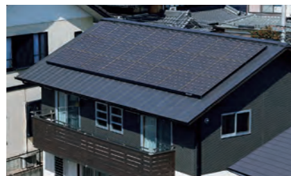
■ 4.70kWシステム (奈良県)
