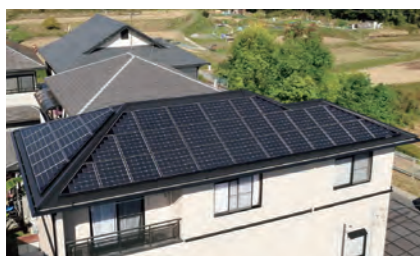
■ 5.64kWシステム (奈良県)
