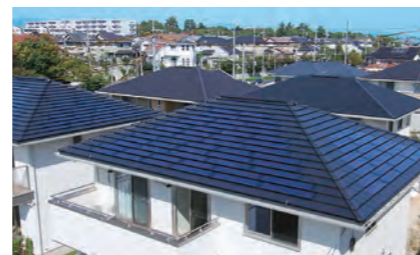
■ 3.06kWシステム (奈良県)
